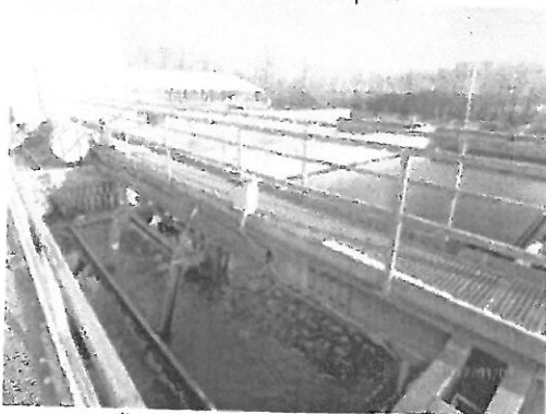
Ülepítő medencék és iszapkotró híd
