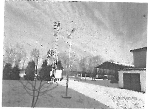
Oszlop transzformátor és kandeláber
